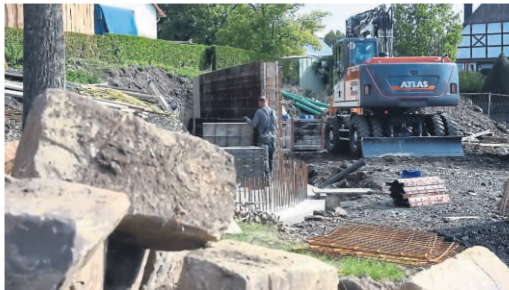
Die Arbeiten am Günner Dorfplatz verzögern sich.
